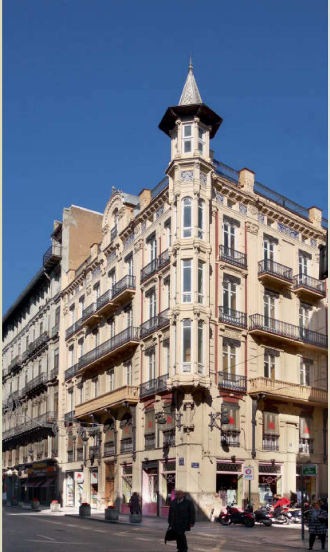
90. Edificios eclécticos pertenecientes a diferentes corrientes estilísticas. La Casa Peñalva, la Casa Sancho y el edificio del Banco de Valencia.
