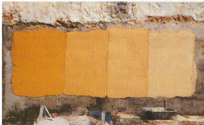
Proceso de ejecución del revoco coloreado
