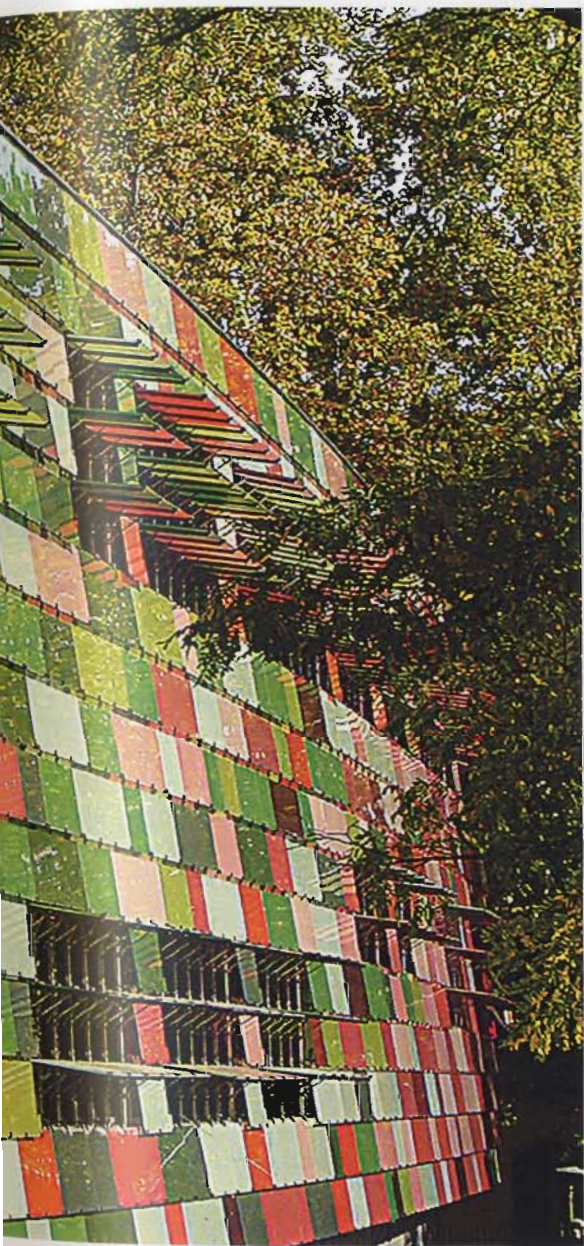
Sauerbruch & Hutton, Stazione di polizia e vigili del fuoco , Berlino, 2002.
