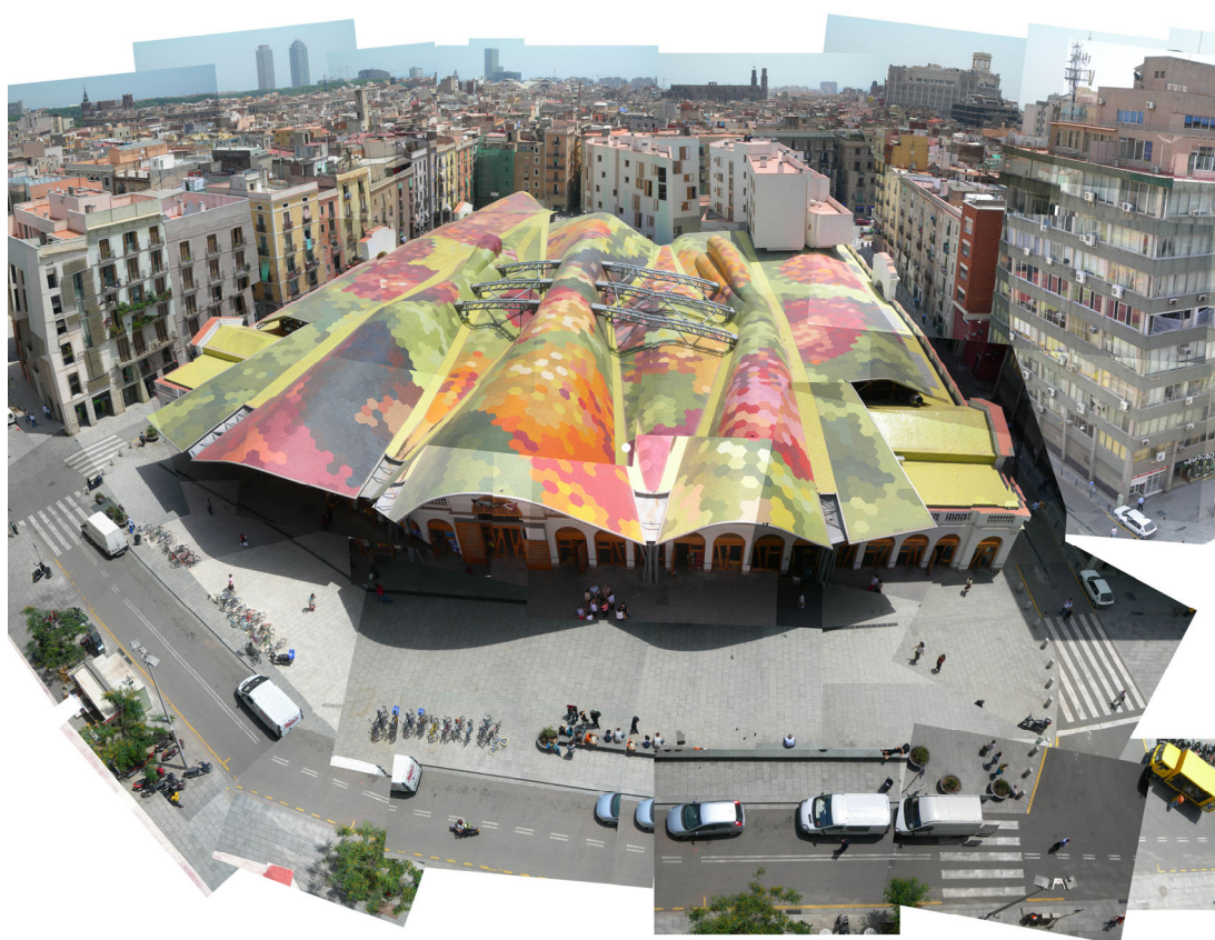
Figura 1. Aspecto General de la cubierta coloreada del Mercado de Sta. Caterina.
