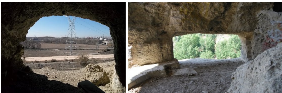
Figura 10. Perforaciones practicadas en las galerías horizontales, a modo de troneras.
