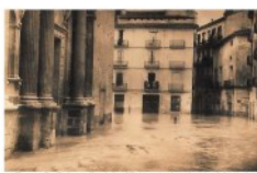
Figura 5: Fotografía del edificio anterior al actual durante la gran nada de Valencia de 1957.
