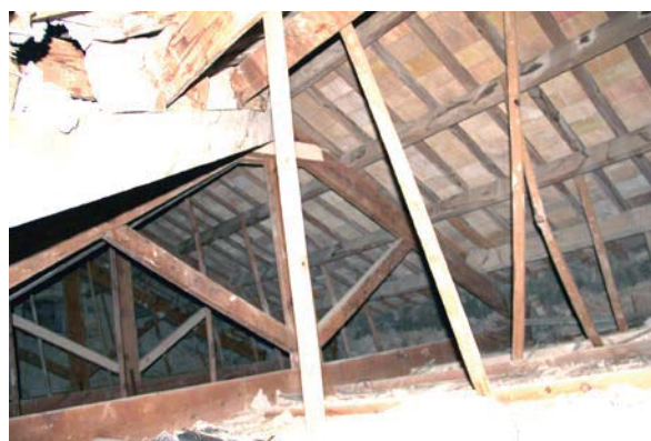
Figura 4: Intrados cubierta. Cerchas de madera.
