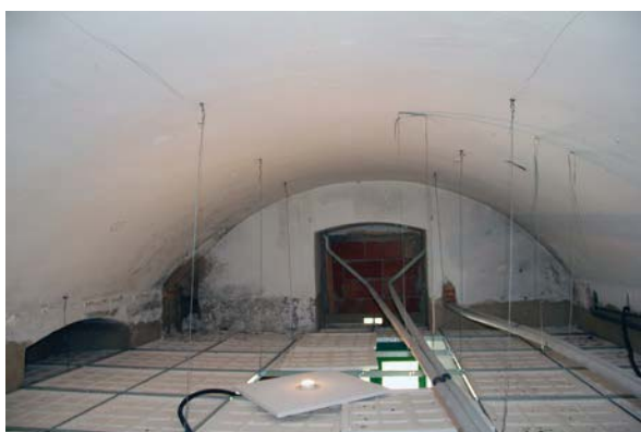
Figura 3: Estructura horizontal entre plantas. Bóveda.
