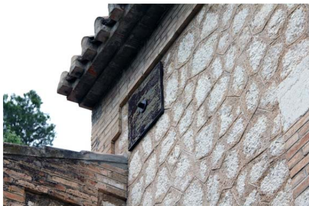
Figura 5: Tirantes estructurales. Estado actual año 2015.
