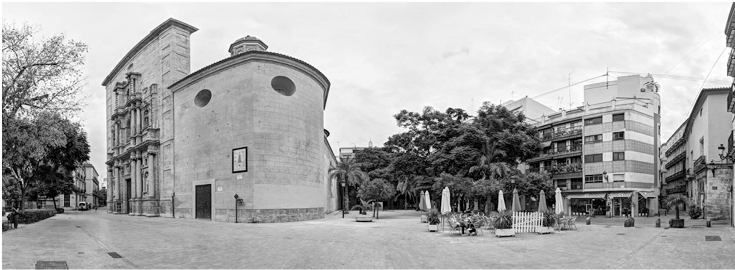
En la que figura un edificio señalado por la legislación como fuera de ordenación (C/ Padre Huérfanos nº7) y que ha sido objeto de estudio
