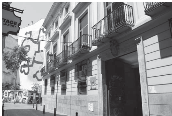
Fig. 2. Current facade of the Old Palacio de los Martínez de Raga, Valencia
