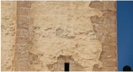
Figura 3. Banda horizontal inferior de sillares fingidos.
