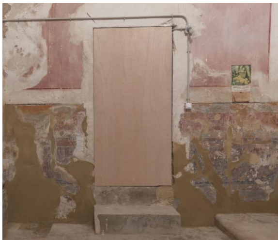
Fig. 9. Saneamiento de muro 2, dejando una ventana histórica. Elaboración propia.
