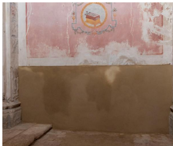
Fig. 10. Saneamiento de muro 1. Elaboración propia.
